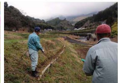
法面への小段設置
